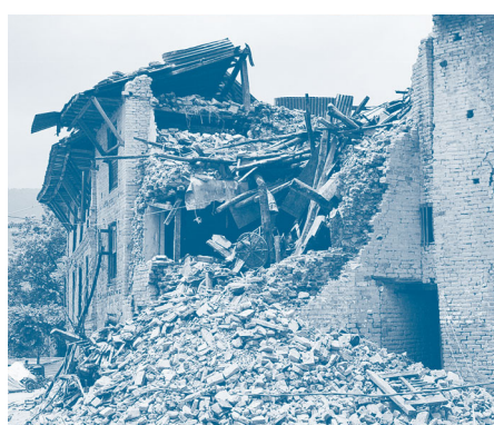
▲ネパール地震発災後の建物崩壊の様子
