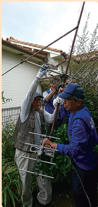
強風により落下したアンテナの撤去作業
